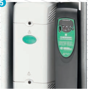
New VSD cubicle
